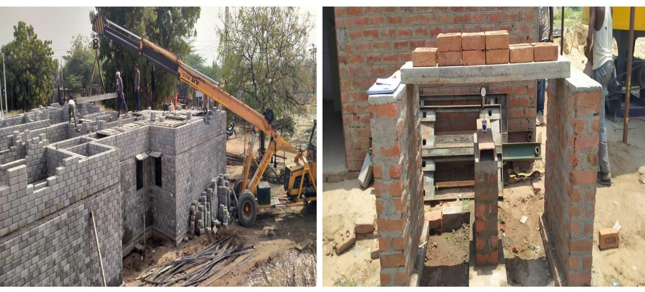
JOIST BEAM AND PLANK INSTALLATION WORK FOR GROUND FLOOR SLAB **PLANK DEFLECTION TEST**
