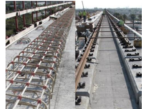
Miami-Dade Metro Project - USA
